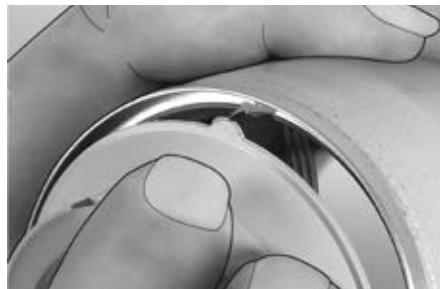
Elektronikenheten med de fixerade kablarna skjuts in i den smorda ingjutningsringen och **trycks fast**. Det skall höras ett tydligt klickljud!
