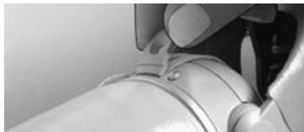
De bandklem onder de ingietring schuiven en met de schroef fixeren.
