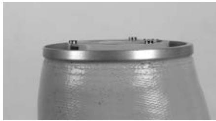
Kontaktplatta och kanten på ingjutningsringen är parallella.
