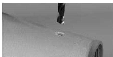
Percer 4 trous de 6 mm de diamètre chacun dans la partie supérieure du bras, juste au-dessus de la bague à couler, afin que l'humidité susceptible de pénétrer en cas de transpiration du patient puisse s'évaporer.
